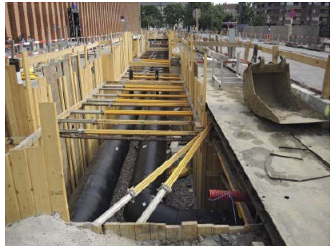
Abb. 3: Derzeit finden in Kopenhagen umfangreiche Baumaßnahmen zur Verlegung von Fernwärmeleitungen statt. Wenn möglich werden diese mit dem Bau von Cloudburst -Maßnahmen kombiniert.
