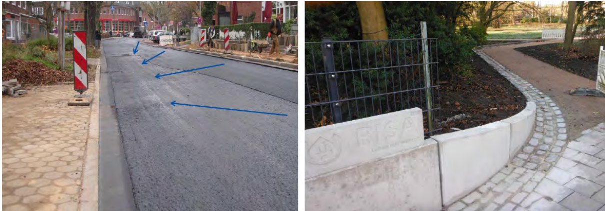
Abb. 11/12: Links: Änderung des Straßenprofils vom Dachprofil zum Querprofil; Rechts: Abfluss in Notwasserüberlauf /Notwasserweg (Fotos: HAMBURG WASSER)
