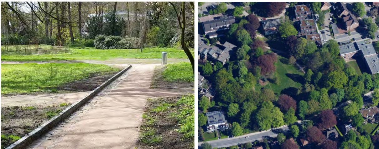
Abb. 13/14: Nach Fertigstellung (Foto: HAMBURG WASSER; Digitales Orthophoto/Schrägluftbild © Freie und Hansestadt Hamburg, Landesbetrieb Geoinformation und Vermessung, www.geoinfo.hamburg.de , Datenlizenz Deutschland – Namensnennung – Version 2.0)
