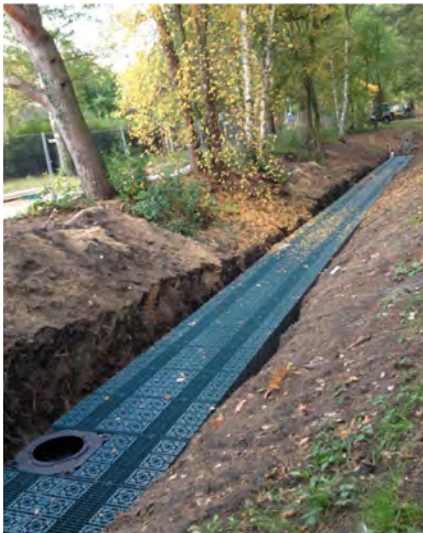
Abb. 9/10: Links: Einbau von Rigolen in den erweiterten Sickergraben; Rechts: Spielplatz mit Flutmulde (Fotos: HAMBURG WASSER)
