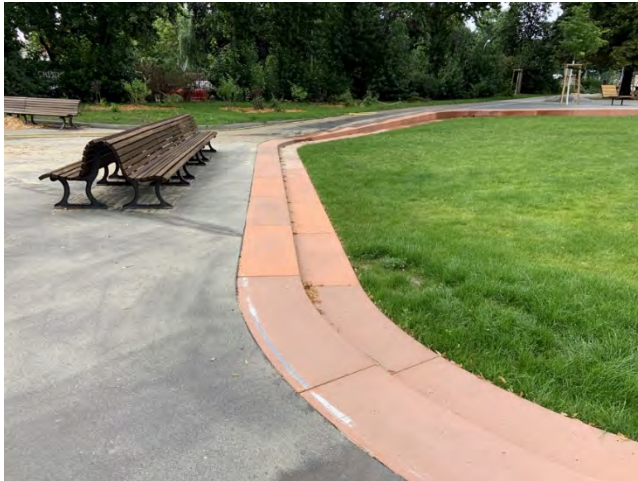
Abb. 7: Über den als Notwasserweg modellierten Parkweg wird im Starkregenfall überschüssiges Regenwasser der Shared-Space-Zone dem Wiesental zugeführt (Foto: bgmr Landschaftsarchitekten)
