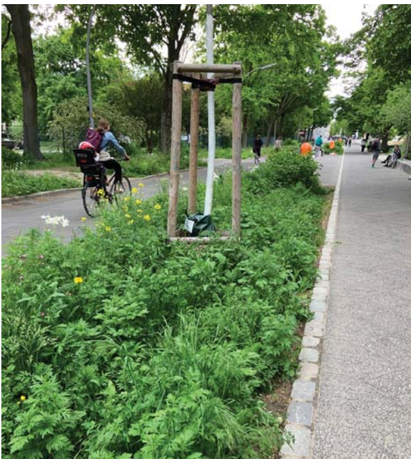
Abb.: 94 Umsetzungsbeispiel für das Konzept überlagerter Systeme mit Oberflächenbeschickung und temporärer Speicherung (Sven Hübner, bgmr)
