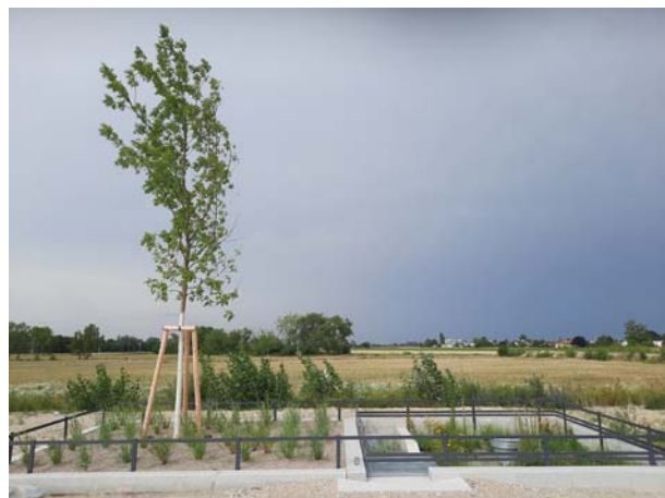
Abb.: 95 Umsetzungsbeispiel für das Konzept entkoppelter Systeme mit Oberflächenbeschickung und temporärer Speicherung (Sieker)
