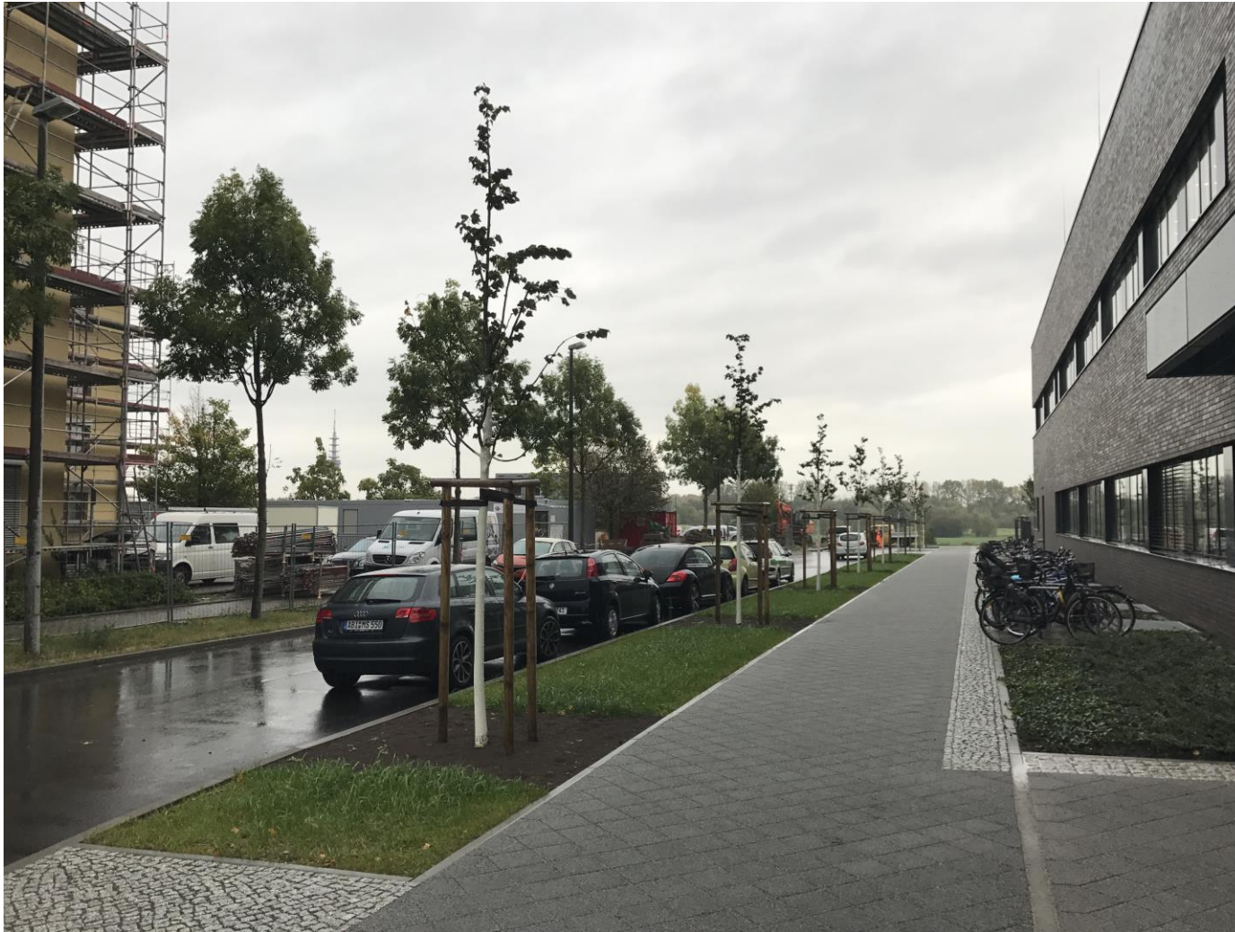
Flächenversickerung mit Tiefbord als Trennung zum Gehweg
