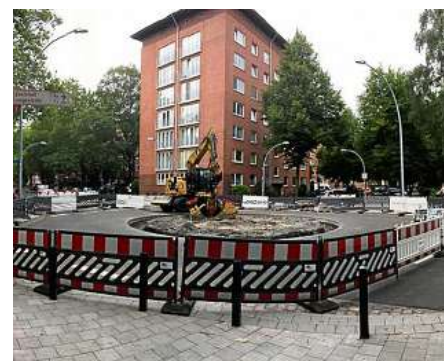
Am Freitag soll der Kreisverkehr am Heußweg fertig sein. FOTO: NICO BINDE
