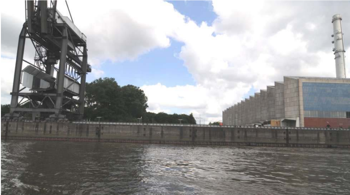
Abb. 4: Ansicht eines Teils des Kraftwerks in Wedel mit Verladekran (links) und Betriebshalle (rechts).
